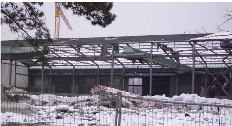
Abriss der ehemaligen Wellershoff-Hallen in Stockum am Rosenthalring, Endphase. Ganz rechts der Hubsteiger, mit dessen Hilfe die Platten ohne Bruchgefahr abgenommen und abtransportiert werden können.
