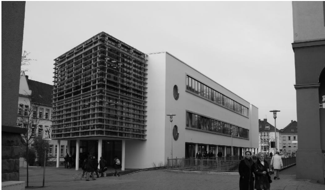
Der PPP - Anbau des Schillergymnasiums
