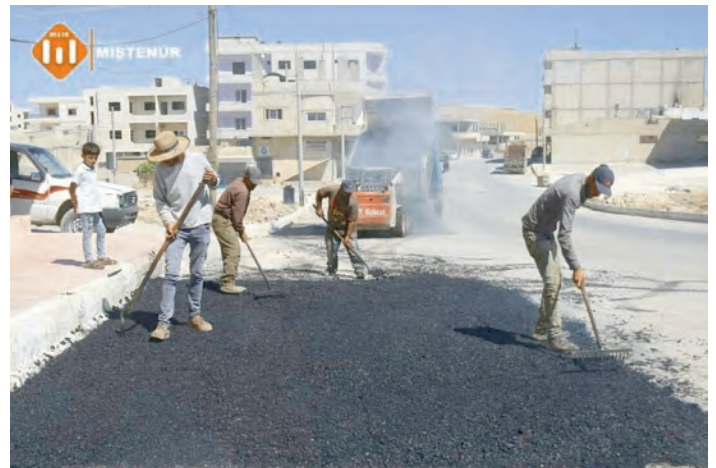
Straßen werden gebaut
